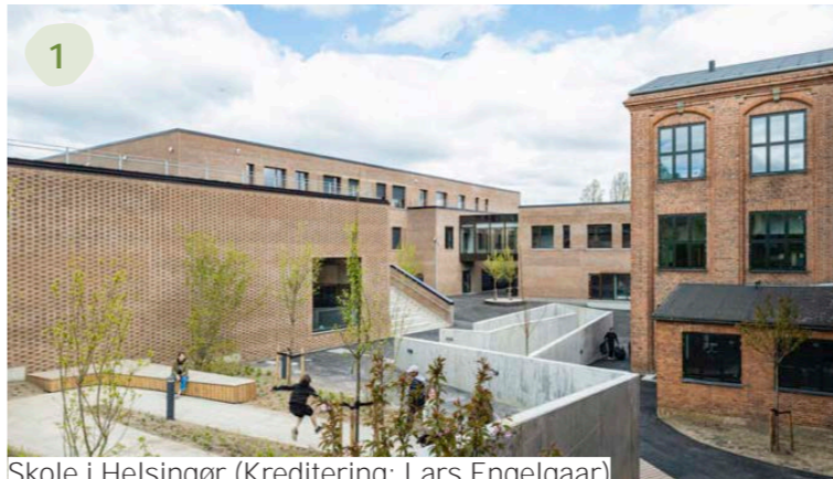
Skole i Helsingør (Kreditering: Lars Engelgaard) Uddannelsesinstitutionerne skal beholdes i bymidten, da de medvirker til at skabe en levende bymidte.
