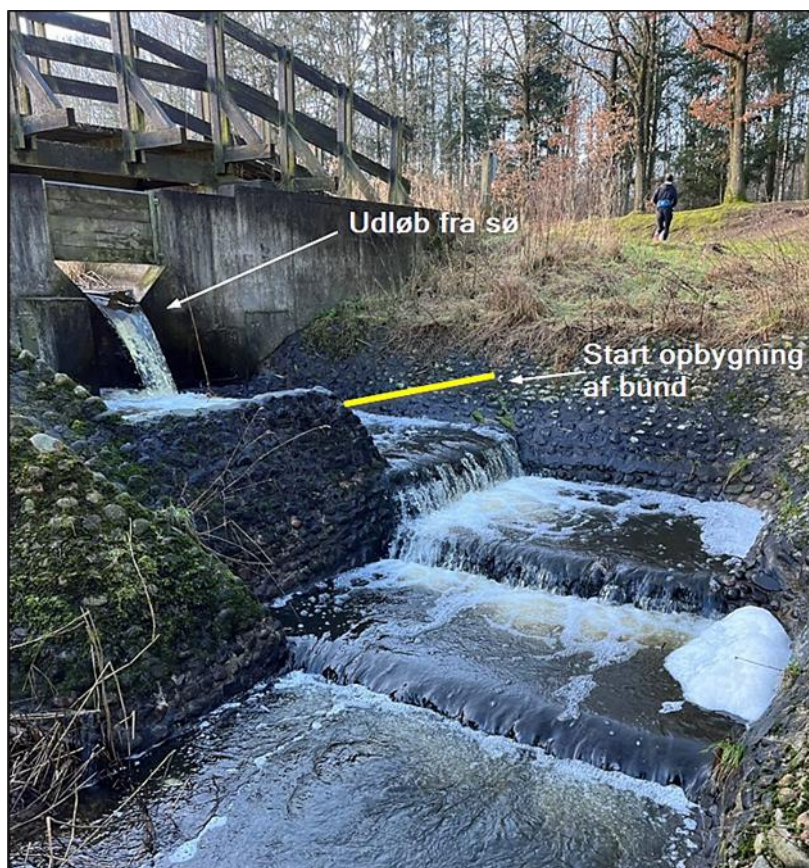
Figur 4-6 Fotoet viser udløbet fra Tvebjerg Sø. Den gule streg angiver der, hvor jernpladen monteres.
