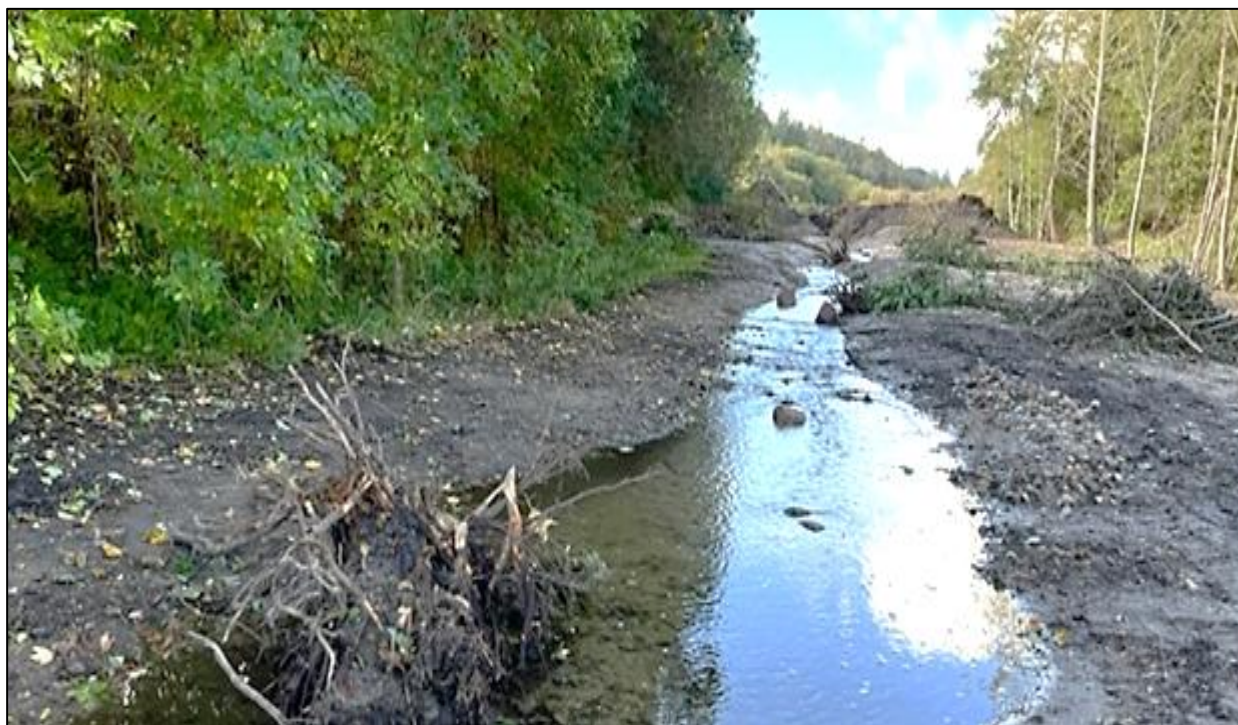
Figur 4-3 Eksempel på rodknold udlagt i lille vandløb. Knoldene i Herredsbækken, skal om muligt være lidt større.
